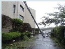
鉾南町庁舎 被災行政棟 /パンダマスト 倒壊
