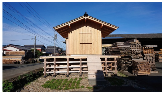
写真9：1尺（300mm）ピッチで割り付けた 外壁板（板目取り）
