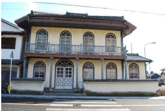
軒切りした明治9年(1876)頃の洋館
