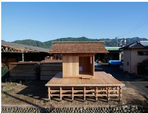
写真8：方丈板倉齋 外観 正面左のケンドンの建具板は 巾300mmの赤柱取り
