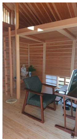
写真3：方丈板倉「齋」の内部 床板は3.5寸巾・白太、 壁板は4.5寸巾・赤身勝ち、 天井は6.0寸巾・源平での木取り
