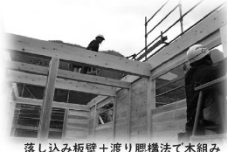
落し込み板壁+渡り脚構法で木組み
