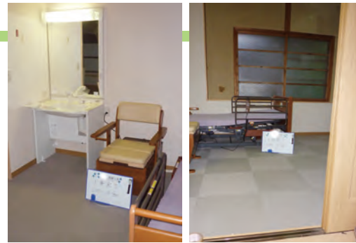
事例2 寝室内のバイオトイレと洗面台(左)。床段差解消後。奥が寝室(右)
