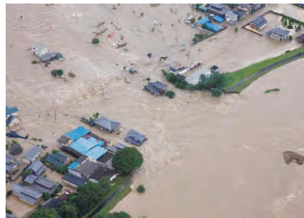
台風の大雨に伴い鬼怒川の堤防が決壊し河川が氾濫し、広範にわたってまちが浸水した(国土交通省資料より)
