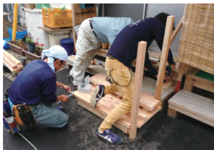
仮設住宅の段差軽減のための踏み段設置
