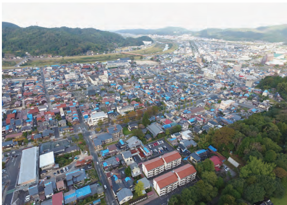
ブルーシートに覆われた街の様子
