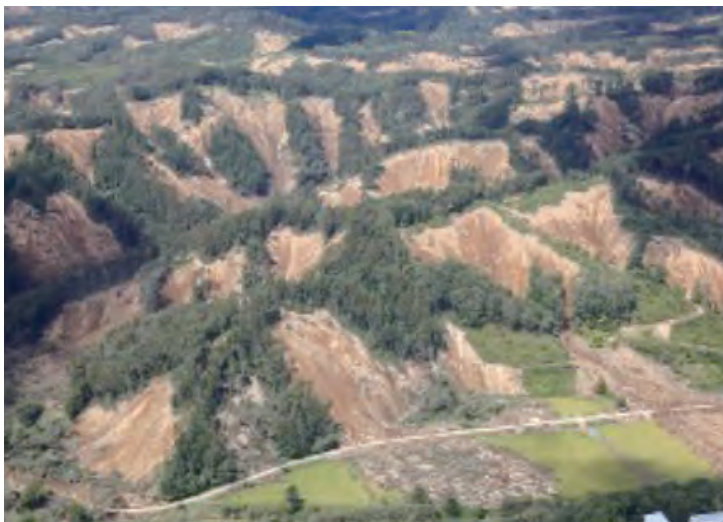
厚真町の土砂崩れの様子
