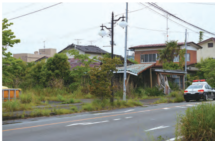
双葉町中心部には、崩れたままの家が建ち並ぶ
