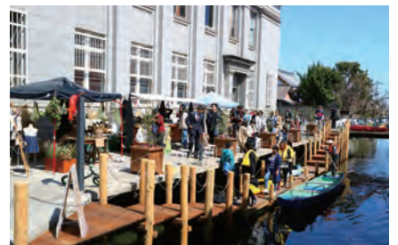
新設された船着き場
