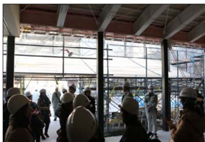
隈研吾氏設計「竹田市城下町交流プラザ」工事現場見学
