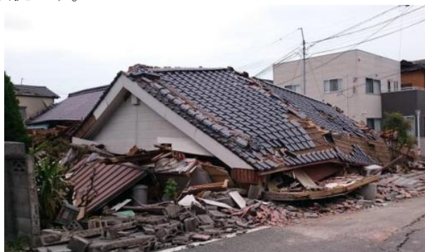
平成28年熊本地震 被害状況
