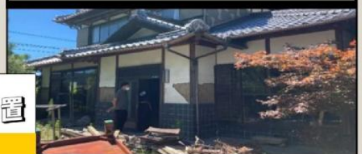
基礎や地盤が良好で建物の損傷も軽い場合
