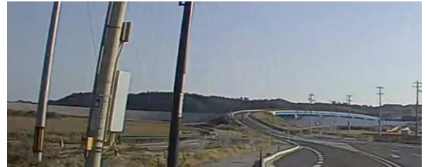
小泉大橋と津谷川護岸防潮堤
