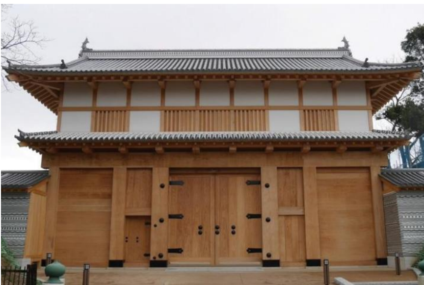
大手門完成写真
