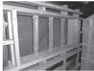
虫籠窓の左官工事下地
