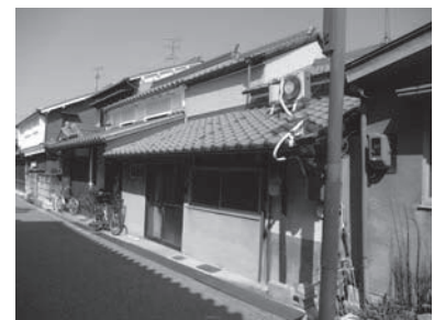
正面外観（改修前）
