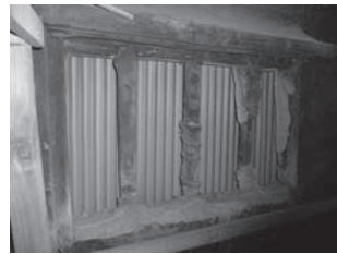
後付け外壁に隠された虫籠窓
