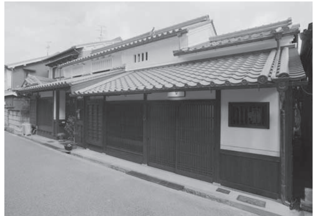
正面外観（改修後）
