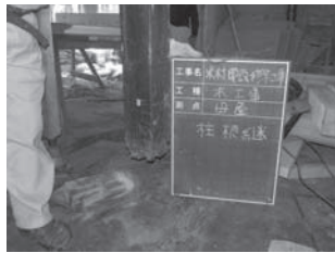
傷んだ部分を切り取り
