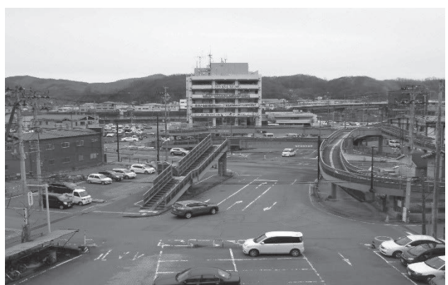
上:被災直後の市役所前 下:現在の市役所前
