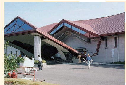
●鳥取県西武地震(2000年10月6日)の被害状況
