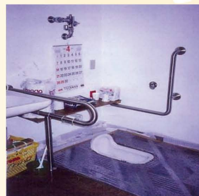
●床を手を使って移動する方のための改修事例。使い勝手がいい和式便器とし、姿勢保持と移動のための手摺を設置
