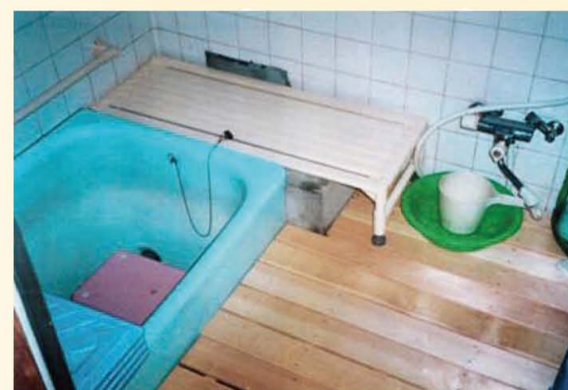
●高齢者の浴室改修事例。浴室の洗い場を木製スノコでかさ上げ。浴槽の横には移乗台を設置
