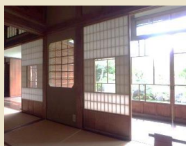
引き分け猫間障子と竹をつるで編んだ開口壁
