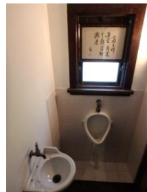
「水洗トイレ」小便器は蛇口を回す方式和便器は上部の箱に水を溜めて流す方式
