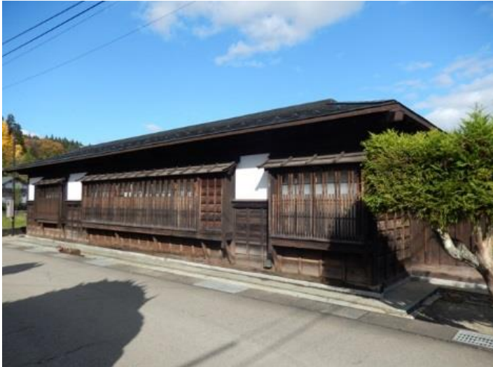
▲西側通り 座敷部
