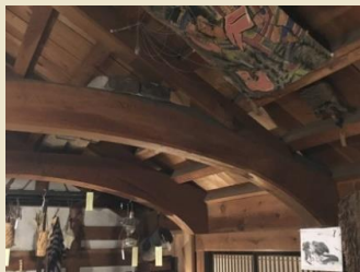
小屋を支える形の揃った鉄砲梁のアーチが見事
