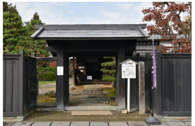
旧伊東家の門構え 若党町の中級武士の代表的な門構えである薬医門に黒板塀の屋敷構えである。
