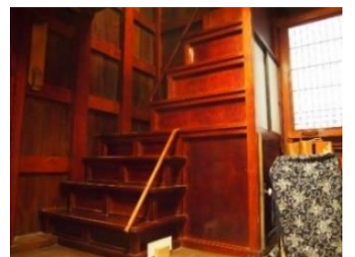
内蔵内部：総漆塗の箱階段
