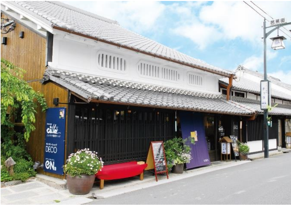
▲大和街道に面し「虫籠窓」「子持格子」など当時の面影を残す外観
