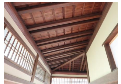
東縁 天井見上げ
