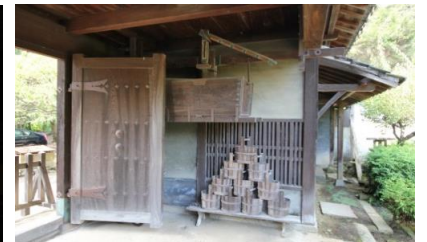
【⑦ 消防設備用の雲龍水】
