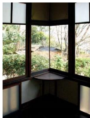
角に柱を設けない手法のコーナー部分を利用した花台
