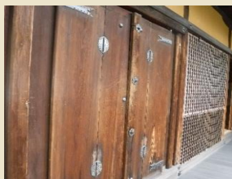
双折板扉(諸折戸) お奥に乗った身分の高い方専用の出入口
