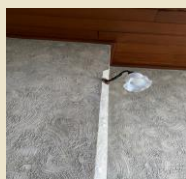
壁の出隅処理
