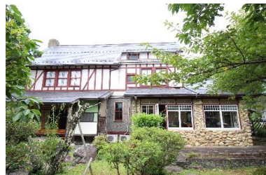
庭側からみた主体部
