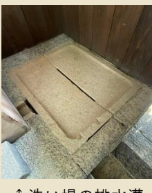
↑ 洗い場の排水溝
