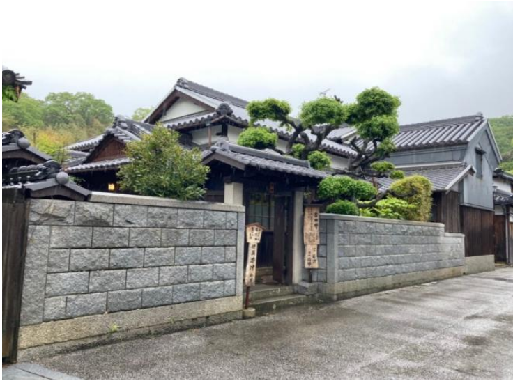
通りに面した外観
