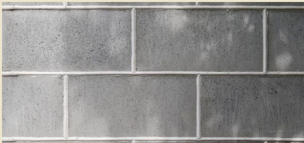
コンクリートブロック土佐漆喰かまぼこ目地仕上げ
