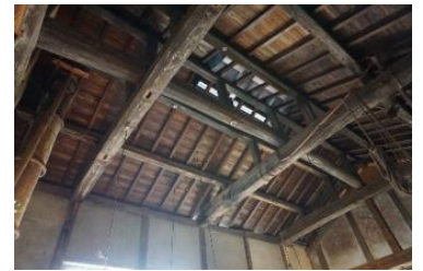
釜屋小屋組み、越屋根を眺む
