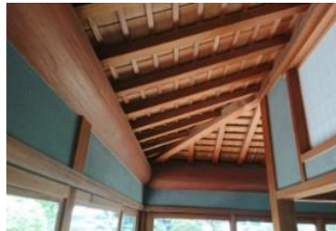
廻り縁天井を見上げる
