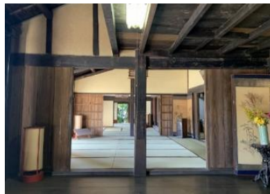
勤定場の床上げ部より座敷をみる
