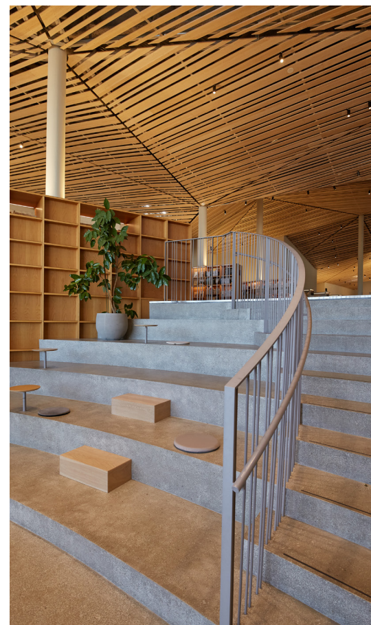
待合スペースも兼ねた正面の階段は、近隣の宇都宮市大谷町で採掘される「大谷石」を粉砕して混ぜた左官仕上げ。
