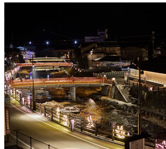
ライトアップされた音信川と橋、その沿道の景観が、長門湯本温泉を象徴する風景となり、恩湯もその一部を担っている。
