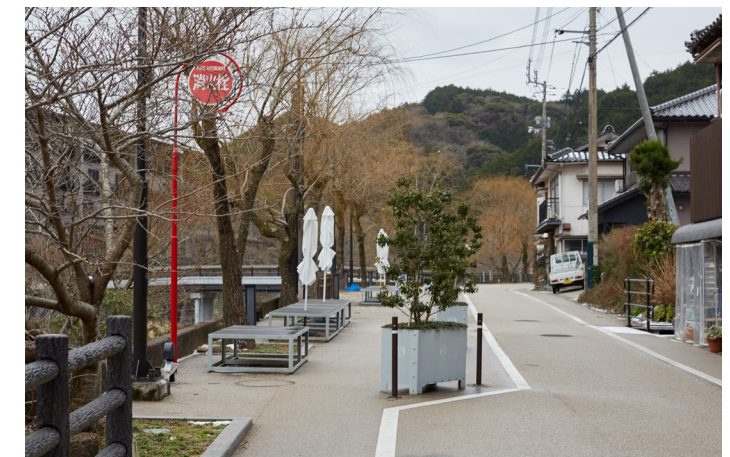
音信川沿いの道路の所々に設けられた狭さく部は、温泉街を“そぞろ歩き”するときの休憩場所として活用されている。この施策で路上駐車がほぼ無くなったとのこと。
