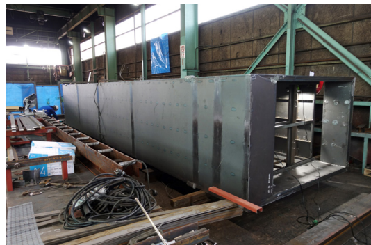
線路至近のため、工場で作成してから運ぶ工程を採用。
