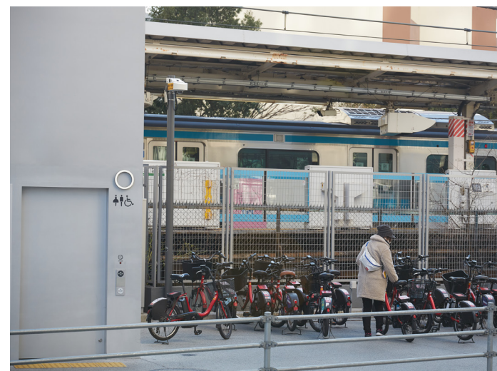
敷地の一部には、下に暗渠が通っているため、そのスペースにはトイレは設置せず、シェアサイクルの駐輪用ポートとして有効活用している。
