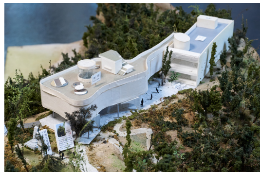
建物模型から地形(等高線)に沿った計画であることがよく分かる。
