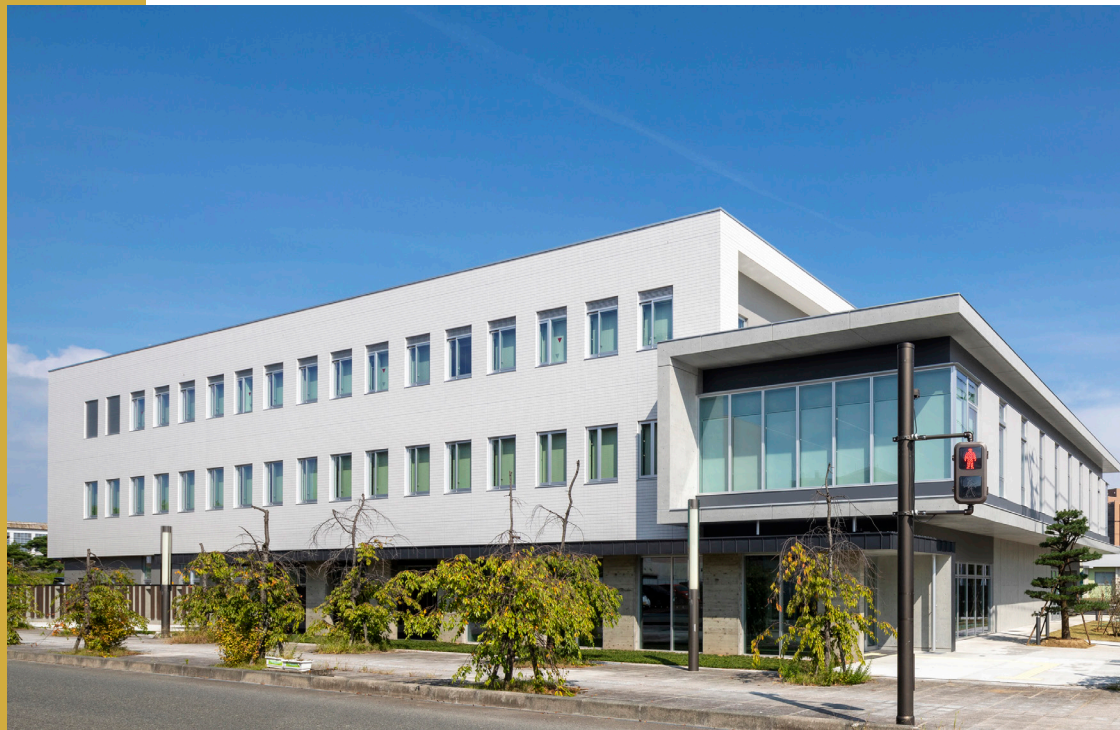
シビックコア内の 鶴岡第2地方合同庁舎の全景。
