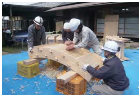
写真1(左) 水輪の組み立て、写真2(右) 友の会・職人・建築士が参加し水車を組み立てた
