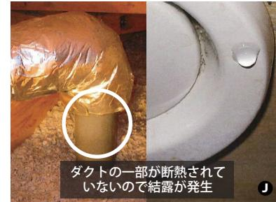
ダクトの一部が断熱されていないので結露が発生 **J**
