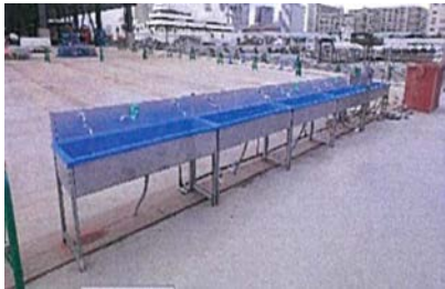
現場の手洗い場所の増設
