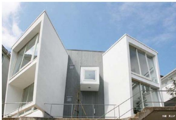
ひな壇造成の住宅地に、周囲の景色を取り込み、家族どうしが気配を感じながら過ごせる家を計画した。周辺環境から窓の位置を検討し、眺望と採光を確保する計画とするため、窓の側面を耐力壁として構造を兼ねた大きな出窓とした。出窓を構造とすることで大開口を自由に配置することができ、開放的な眺望と採光を実現した。
