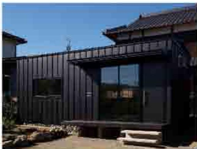
テーマは“市中にある普通のもの”を使用し、“どこまで満足な空間を得られるか。”だった。建築の各部分の機能性、耐久性を再考し、環境性能にも配慮し、十分なコストパフォーマンスが得られた。引違いサッシの中方立の前に柱を通すことで、サッシにより木組みが分断されないで開口部の機能性を確保したシンプルな見え方にできた。黒い表皮をまとい、それを内側から木組みで支える空間“ブラックボックス”的なコンセプトが実現できた。
