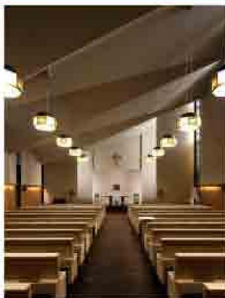
築50年の聖堂の建替え計画。東に既存病院、西崖下に住宅地という敷地条件の下、西側が高い片流れの形態と再利用したステンドグラス越しの西日により、旧聖堂がもつ黄金色の空気感を再現した。新考案の折れ屋根・折れ壁構造により柱・梁の無い大空間とシンボリックな外観を実現。光と影が印象的な祈りの空間を創出した。
