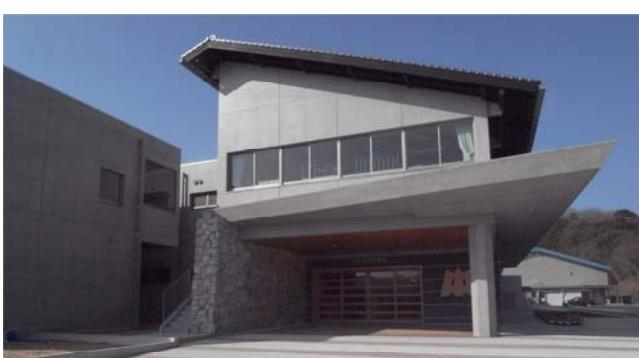
大嶺中学校設計にあたり、生徒一人一人の学びのきっかけとなるしかけを随所に散りばめた、設計を心がけ、かけがえのない仲間との絆を生み出す一つの大きな家のような、一体感のある象徴的な空間を作り出すように考慮しました。美祢市の中心として地域のシンボルとなるよう、伝統的で信頼性の高い瓦屋根を採用し、全体をL字型建物とし、ホールを兼用した吹抜けを設け、外観意匠上および廊下と各部屋の中に、柱型を出さないよう、壁式ラーメン構造を採用しました。また多目的ホールと特別教室棟の屋根構造は木造を採用し、小屋組みの見える木の温かみのある空間とし、校舎全体から黒板、室名札の細部に至るまで手作り感のある建物となるよう設計しました。
