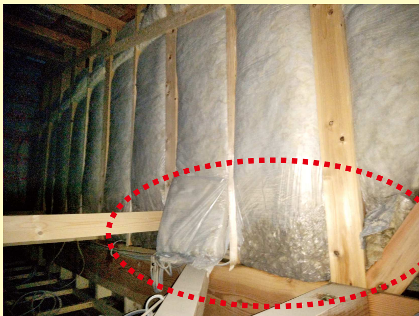
水(泥水)を吸った断熱材
