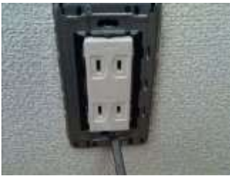
コンセントプレートをはずすと仕上げ材料の湿り具合などがわかる。
