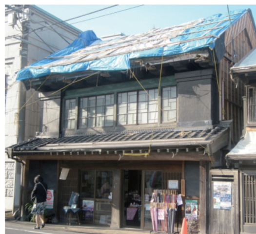
写真10. 屋根全面をブルーシートで保護した事例(千葉県)
