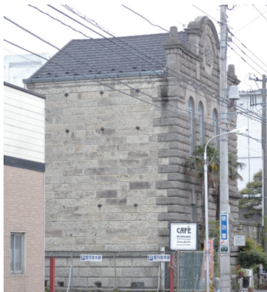
写真13. 新建材で葺き直した事例（栃木県）
