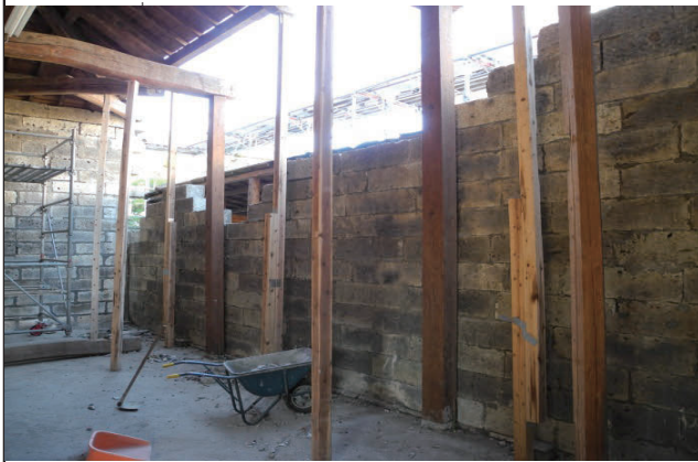
写真説明 内部：軸部の応急支柱と外壁の解体
