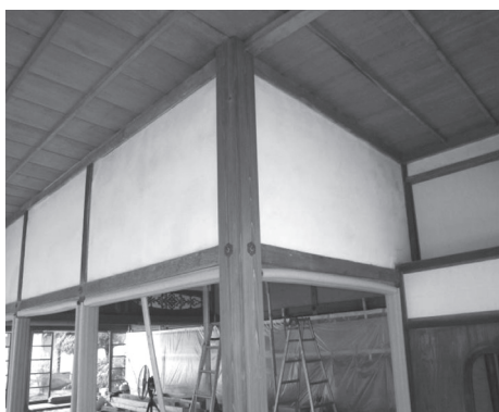
写真11 広間隅柱の添え柱補強
