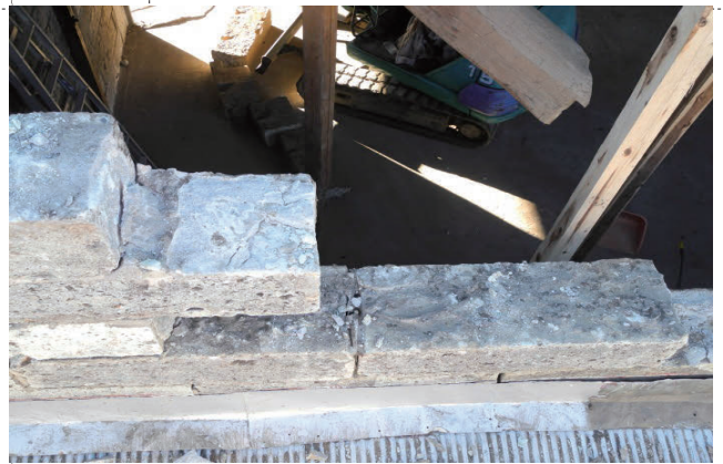
写真説明 外壁の石積
