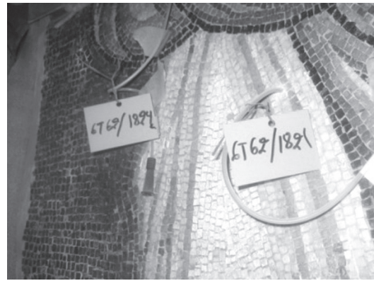
写真5 モザイク画を有する壁面のホワイトセメント注入による亀裂の修復
