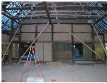
写真13 民家内部の応急措置 (岩手県)
