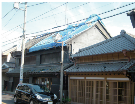
写真9. 部分的にブルーシートで保護した事例(千葉県)
