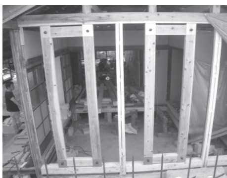
写真12 応接間（床組・小屋組・外壁）の半解体 修理および追加リブフレーム
