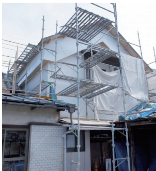
写真8. 仮屋根を上から架けた事例（群馬県）
