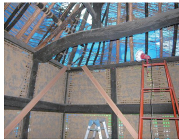
写真14 民家内部の応急措置 (岩手県)
