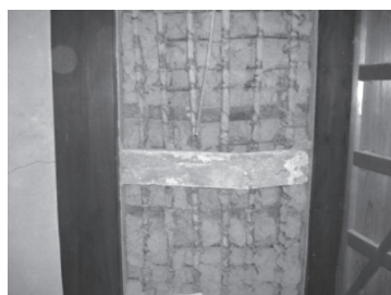
写真1 貫の破損
