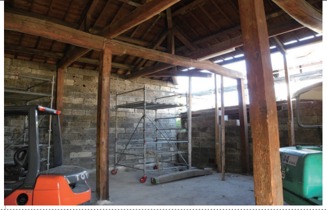
写真説明 内部：軸部の応急支柱と外壁の解体
