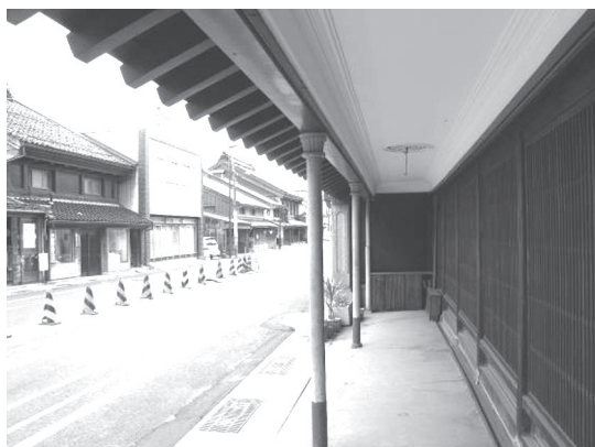
写真37 下屋庇の鋼管支柱(富山県)
