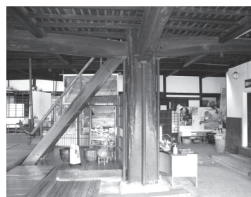
写真32 梁の脱落防止措置 (山梨県)
