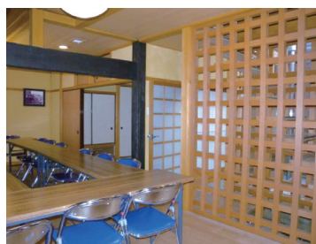
写真24 面格子の耐震化事例 (奈良県)
