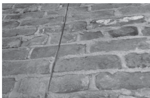
写真7 CFRP帯を用いた補強後の煉瓦壁
