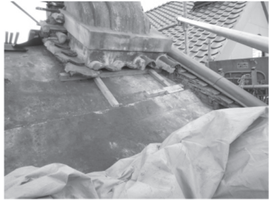
写真3 役物（鬼瓦）の再利用（千葉県）
