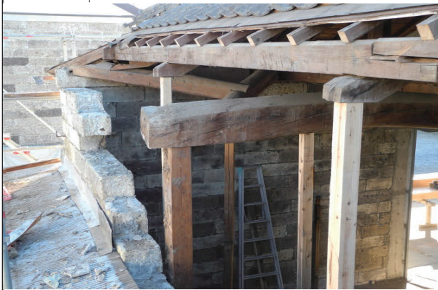
写真説明 垂木の切断 (工事のための措置)
