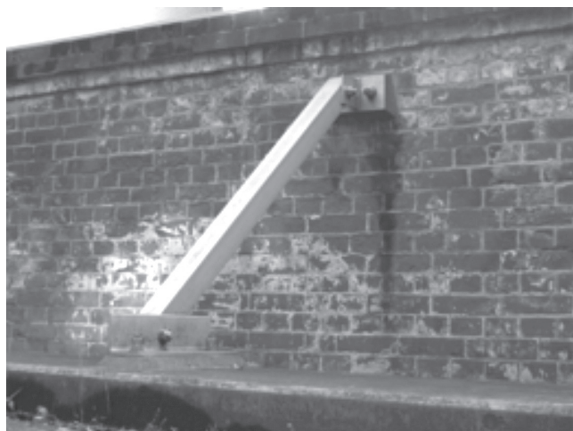
写真24-2 岩崎家住宅レンガ塀の補強 (東京都、重要文化財)
