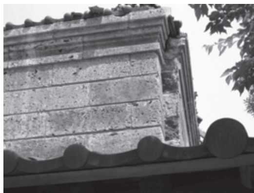
写真17 濱田庄司記念益子参考館3号館（左）および2号館（右）（栃木県、未指定） 大正期の大谷石蔵を昭和51年位現在地に移築。その際、内部に壁とは離してつくられたRC造のラーメンフレームで補強してあったが、壁面隅部に亀裂が生じた
