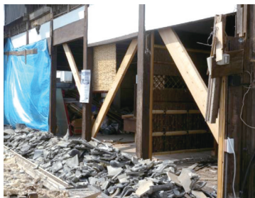
写真16 民家内部の応急措置 (栃木県)
