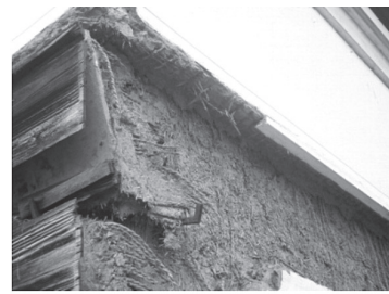
写真6 下げ縄や樽巻きの破断
