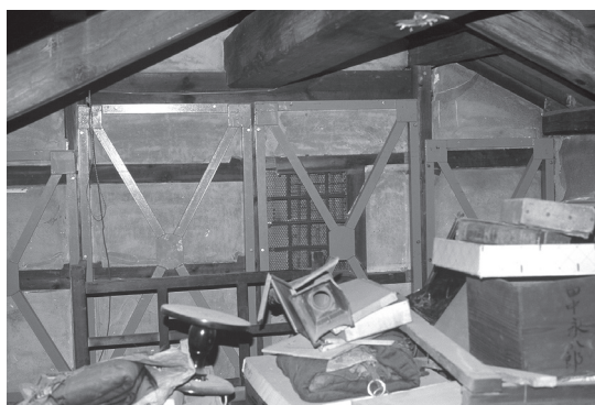
写真39 軸組の補強(兵庫県)
