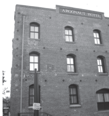
写真23 サンフランシスコでのレンガ造建築の補強 鉄骨のタイバーで壁が外側に倒れるのを防いでいる (外壁の黒い突起はタイバーの留金)
