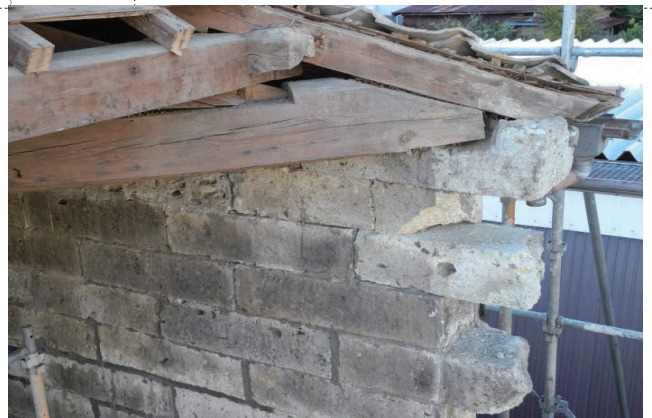
写真説明 北東隅の状態
