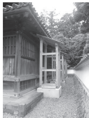
写真36 転倒防止(栃木県)
