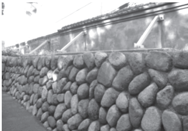
写真24-1 岩崎家住宅のレンガ塀の補強 (東京都、重要文化財)
