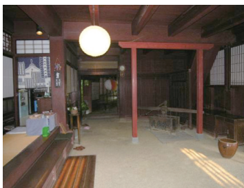
写真20 梁の応急措置 (愛媛県)
