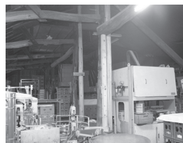
写真33 梁の脱落防止措置 (茨城県)
