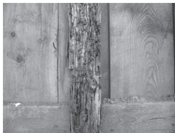
写真5 柱の腐朽
