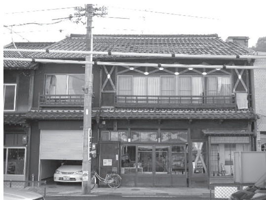
写真38 町家の構造補強(鳥取県)
