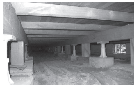
写真9 物置部分の床束補強
