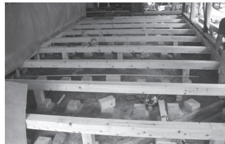
写真8 広間の床組補強・足固め施工
