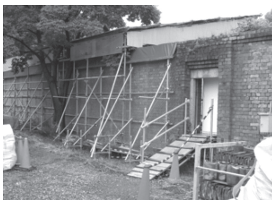
写真22 旧諸戸家住宅・レンガ塀 (三重県、重要文化財) 鋼管による応急措置 (修理工事の際)
