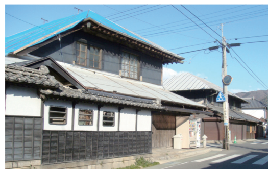
写真12. 屋根を金属板で葺き替えた事例（茨城県）
