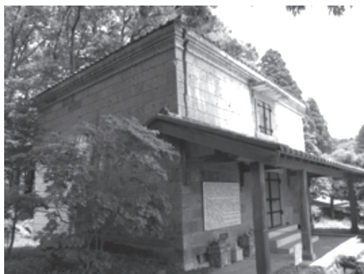
写真17 濱田庄司記念益子参考館3号館（左）および2号館（右）（栃木県、未指定） 大正期の大谷石蔵を昭和51年位現在地に移築。その際、内部に壁とは離してつくられたRC造のラーメンフレームで補強してあったが、壁面隅部に亀裂が生じた
