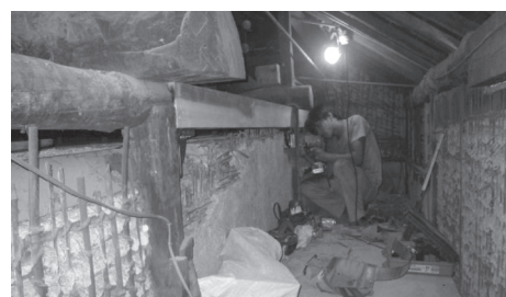
写真9 物置部分の床束補強
