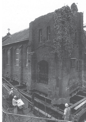
写真8 日本聖公会川口基督教会のジャッキアップ工事 21)
