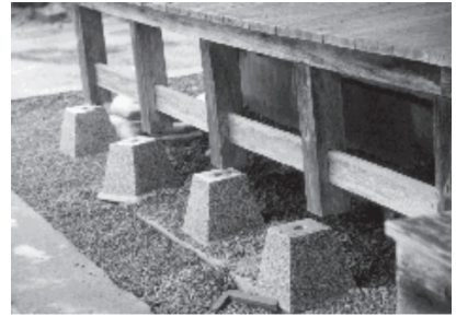
写真1-9 基礎からの移動
