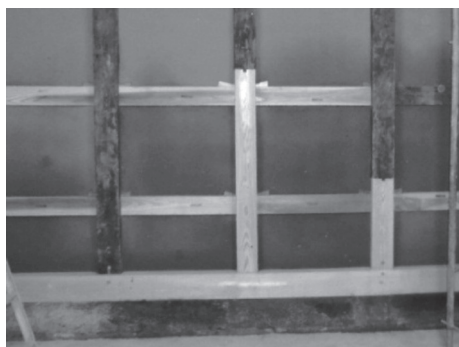
写真1 部材の交換例
