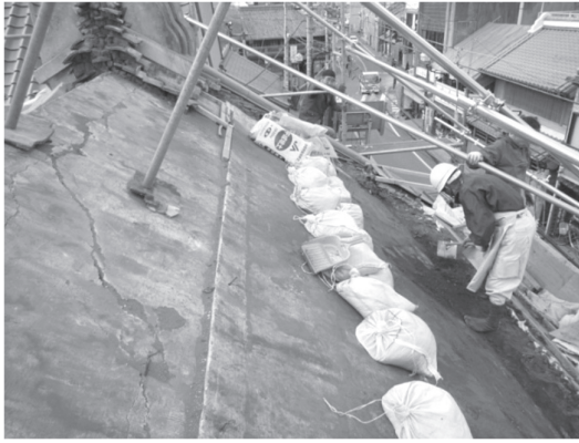
写真2 葺き土の撤去（千葉県）
