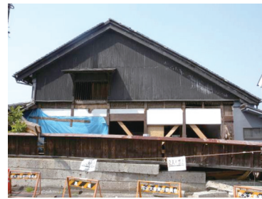
写真15 民家内部の応急措置 (栃木県)
