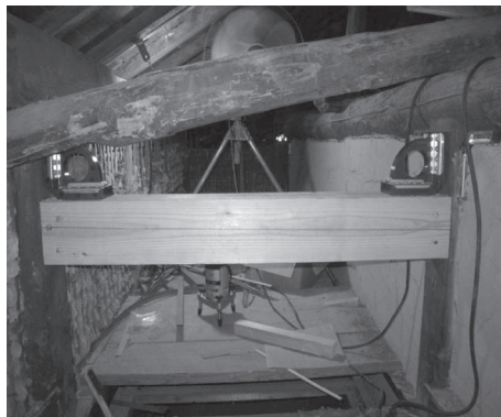
写真6 大書院の耐震リングR10設置状況
