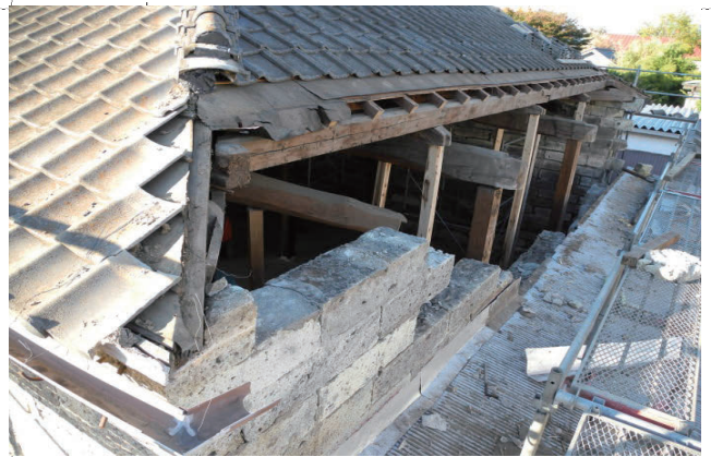
写真説明 外部：外壁の解体
