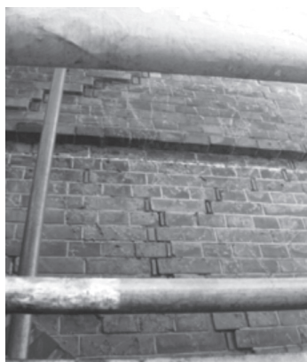
写真20 煉瓦蔵「野村」(茨城県、未指定) 外からの壁面のサポート
