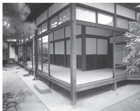
写真13 浄土院大書院（改修工事完了）
