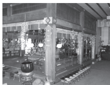
写真28 鴨居の脱落防止措置 (香川県)
