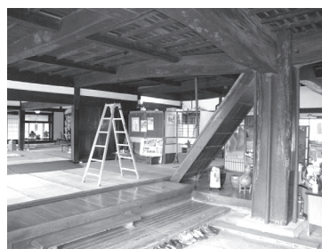
写真31 梁の脱落防止措置 (山梨県)
