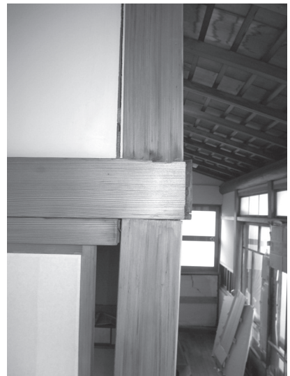
写真1-11 柱の折損
