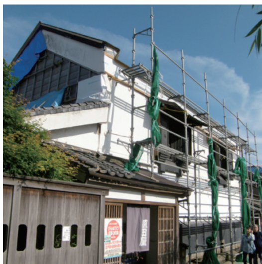
写真7. 波板鉄板で仮屋根を葺いた事例（千葉県）
