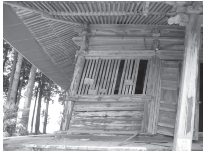
写真1-6 軸部の傾斜
