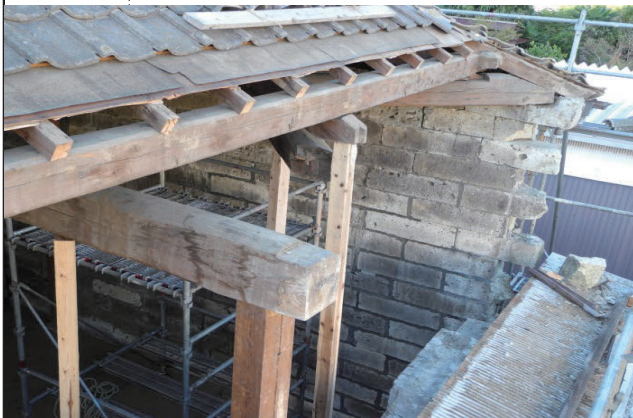
写真説明 解体中
