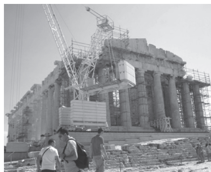
写真9 地震で被災した部分の解体修理（ギリシャ・パルテノン神殿）
