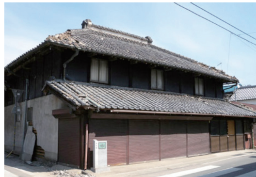
写真4. 降り棟の崩落した屋根(茨城県)
