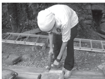
④ 【ドリルで穴あけ】
