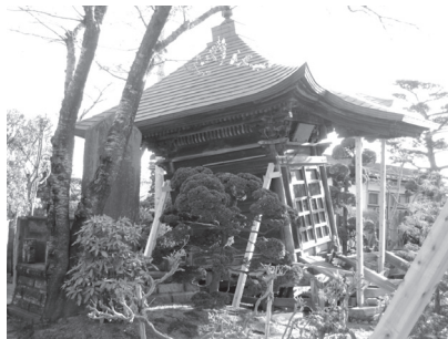
写真1-7 軸部の傾斜
