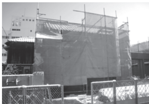
写真19 煉瓦蔵「野村」(茨城県、未指定) 外壁の落下に備えた養生
