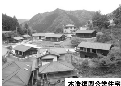
木造復興公営住宅
