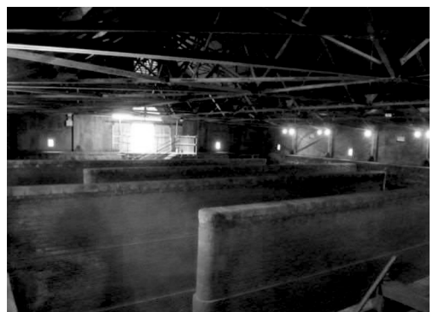
写真2 北吸配水池の内部写真
