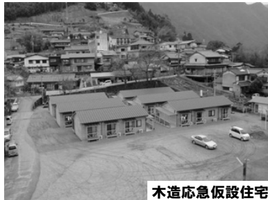
木造応急仮設住宅
