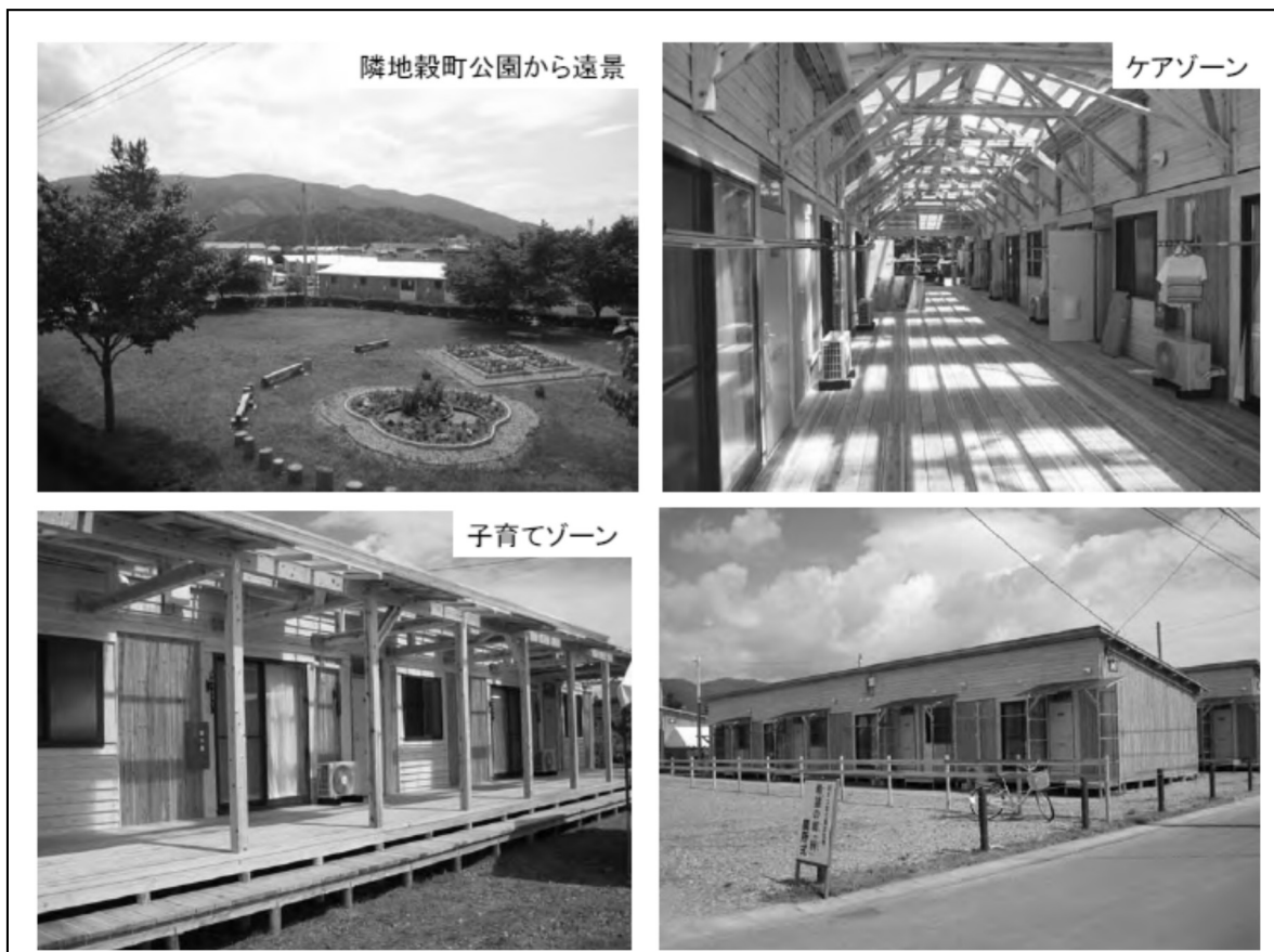
遠野市 穀町仮設住宅地
