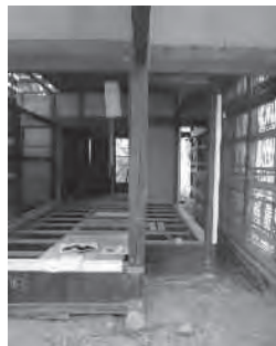
修復前の通り土間 幅は半間
