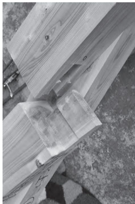
トラスの仕口は伝統工法。ほとその部分の一部プレカットを活用
