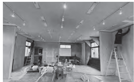
2階ホールの改修DIYの様子
