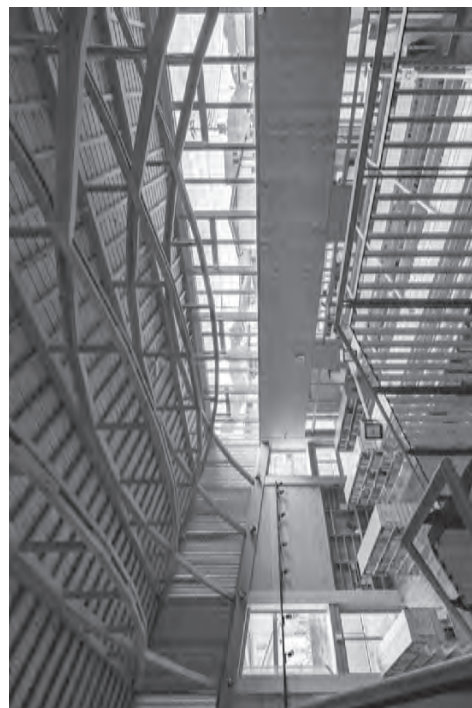
住宅に使う程度的一般製材部材を組み合わせてつくったスパン16.2mの無柱空間
