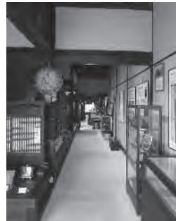
修復後の通り土間 1 間幅
